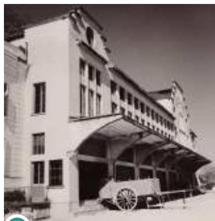
33 ↑ Terrasse avec charette avant construction rincerie © Gratien-Meyer
