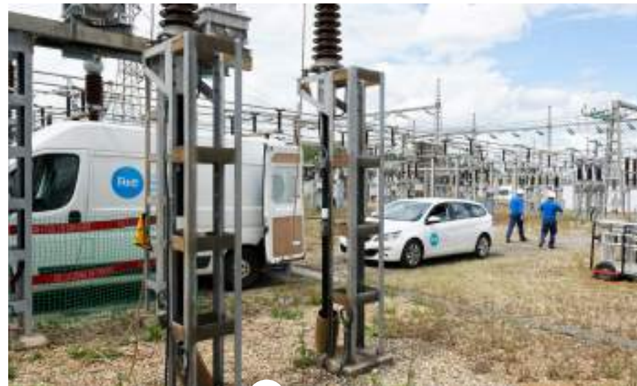
↑ Chantier dans un poste électrique © Pôle RTE, GMR Anjou
