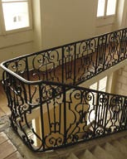
Escalier de l'hôtel Weygand, 25 rue du Temple.
