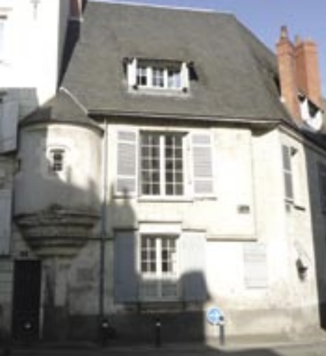
Maison de Marc Duncan, 6 rue du Puits-Tribouillet.
