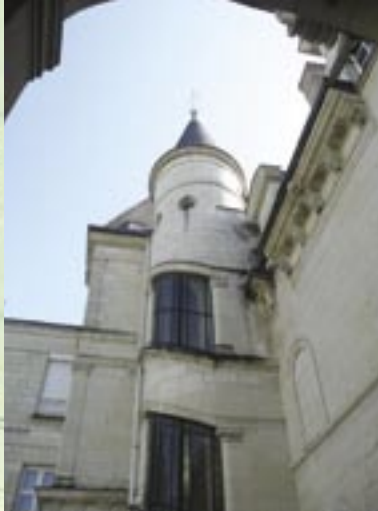
Hôtel des Abbesses de Fontevraud, 6 rue de l'Ancienne Messagerie.
