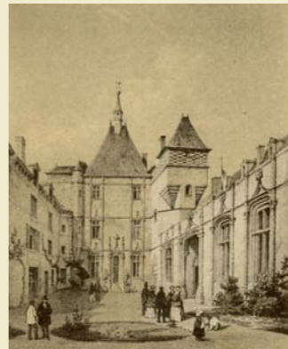
Façade sur cour avant 1858. A droite, l'aile construite en 1841. A gauche, le corps de logis construit par Duplessis-Mornay
